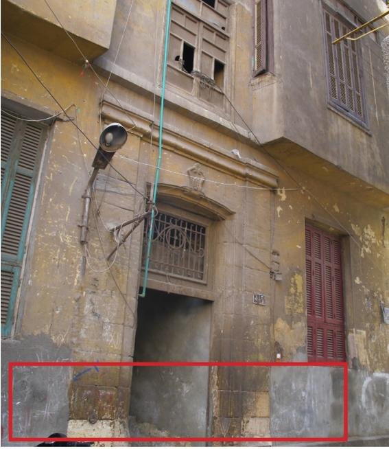
الشكل (١٤٧) - بقعة رطوبة خفيفة نتيجة المياه الجوفية تؤدي إلى تآكل المواد الإنشائية للمبنى، في هذه الحالة تم حل المشكلة جزئياً بالخرسانة لكن البقع تعاود الظهور على شكل سطح خفيف الضرر.
