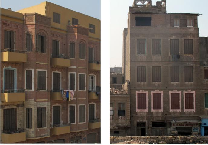
الشكل (١٢٩، ١٢٩ب) - مثالان على تشطيب الطوب، حيث تعتمد التصميم أن يكون الطوب المكون للحوائط الحاملة هو التشطيب للمبنى.
