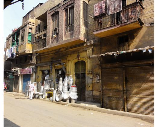
الشكل (١٥٢أ، ١٥٢ب، ١٥٢ج) - مثال لحالة حفاظ مقبولة، بعد أن نالت هذه المباني درجة مقبول في أغلب الأجزاء السابقة. إنشاءات المبنى سليمة لكن توجد بعض المشكلات مثل التعرية أو بقع الرطوبة أو شروخ خفيفة.
